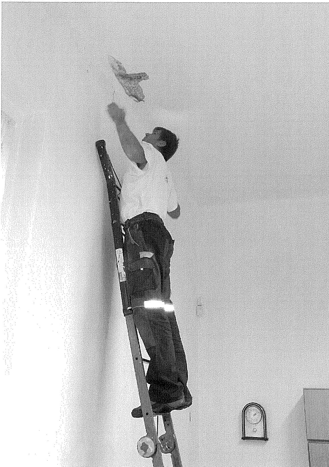
Sonda S1a - endoskopický průzkum v místnosti 165, uvolněná podhledová omítka
