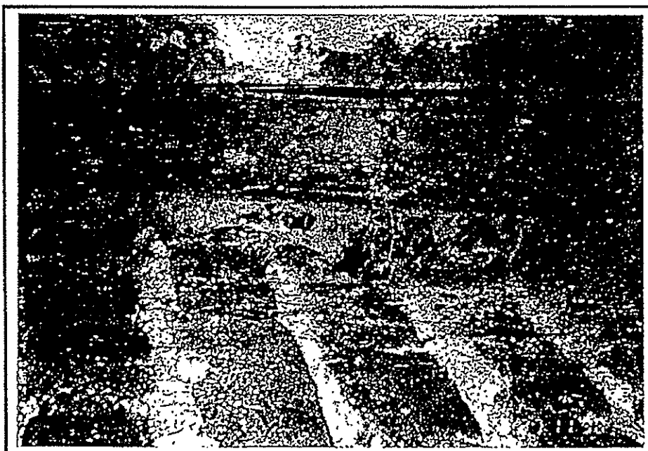
Foto č. 4 Sloupek v krovu porostlý dřevomorkou
