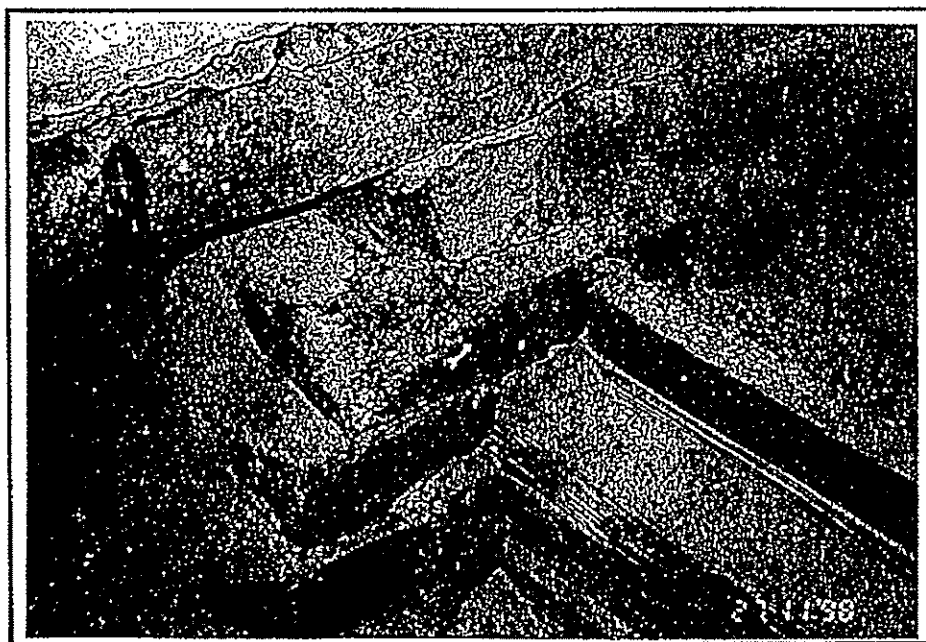
Foto č. 8 Spáry prorůstající myceliem houby
