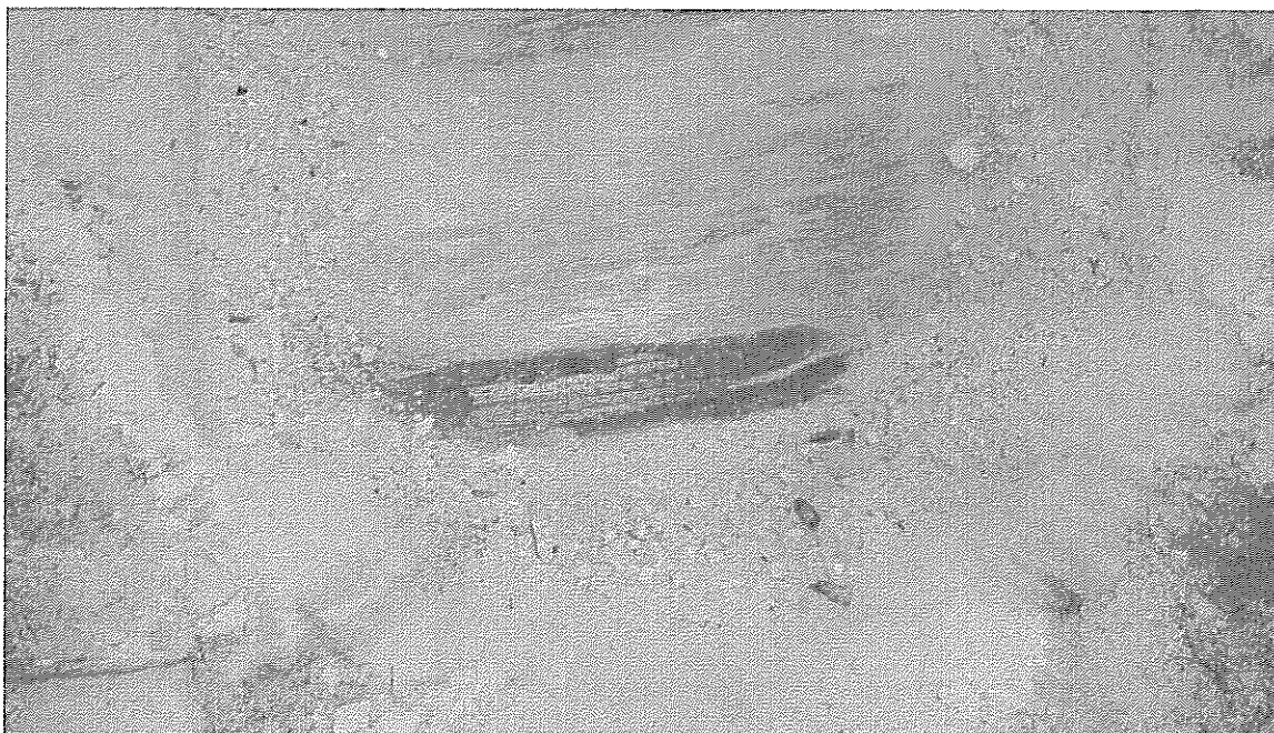
Sonda S5 – odkrytý záklop v sondě se znaky napadení dřevokaznými škůdci
