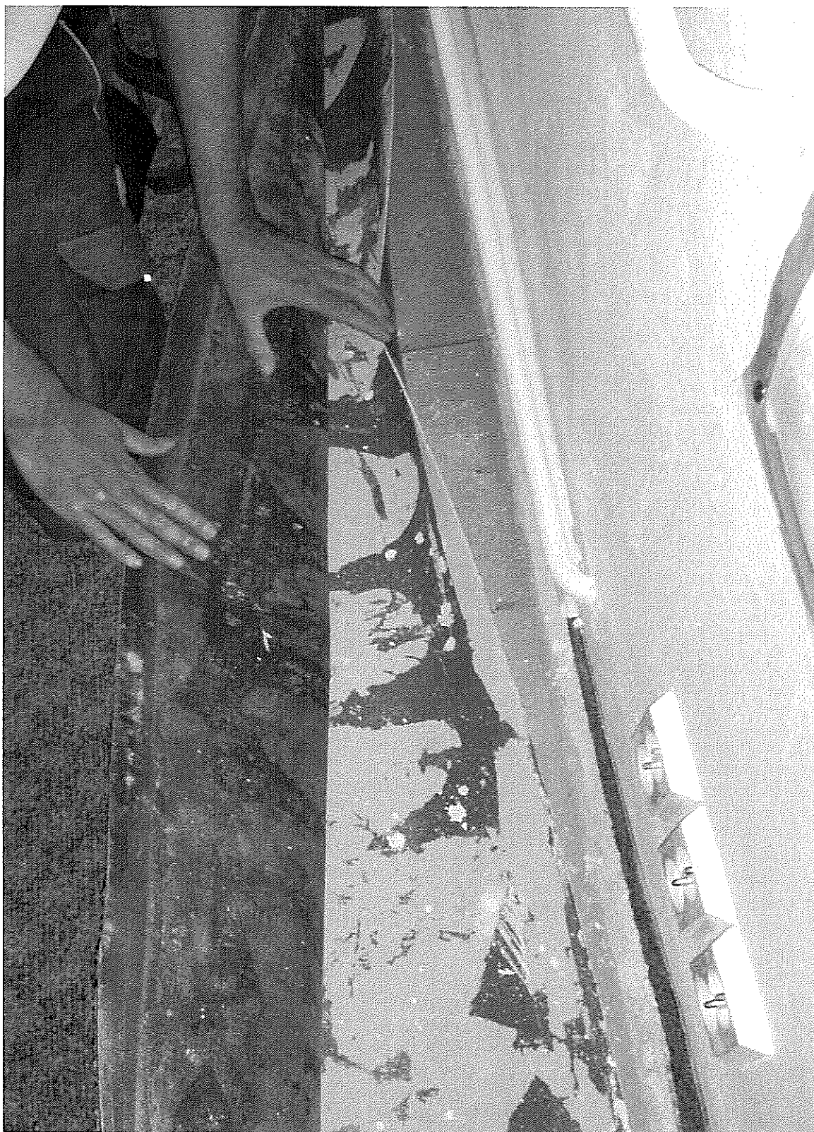
Sonda S1b – skladba nášlapných vrstev podlahy v místnosti 267 nad místností 165
